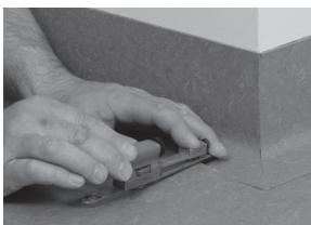
Odřízněte podlahovou krytinu, která bude položena na lem
